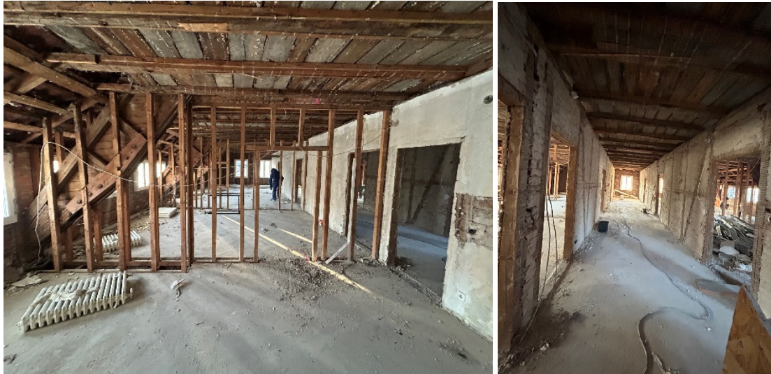
Abbildung: Arbeiten im Gebäudeinneren. Fotos: Stadt Burgdorf.
