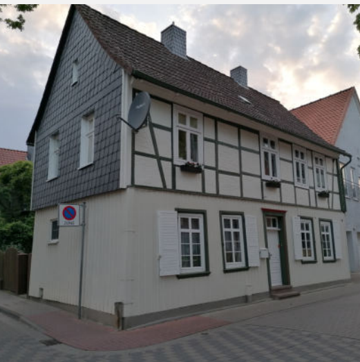
GEFÖRDERTE FASSADENSANIERUNG EINES GEBÄUDES IM WÄCHTERSTIEG: VOR DER SANIERUNG, WÄHREND DER SANIERUNG UND NACH ABSCHLUSS DER BAUMASSNAHMEN.
