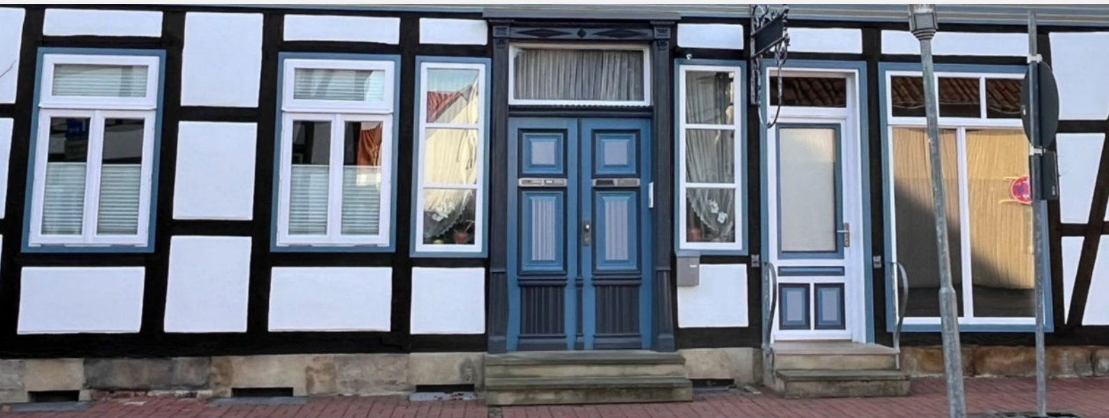
VIelfalt der Gebäudetypen und Fassaden in der Innenstadt.
