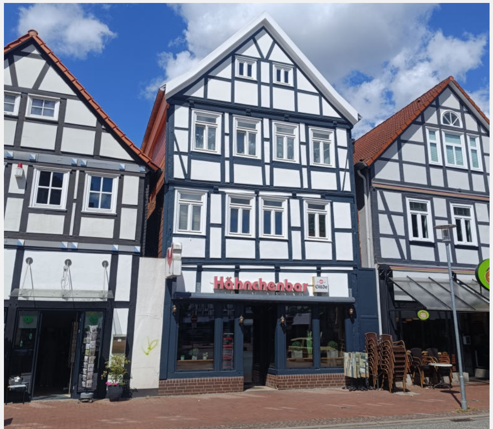
GEFÖRDERTE SANIERUNG EINES GEBÄUDES IN DER MARKTSTRASSE: VOR DER SANIERUNG, WÄHREND DER SANIERUNG UND NACH ABSCHLUSS DER BAUMASSNAHMEN.
