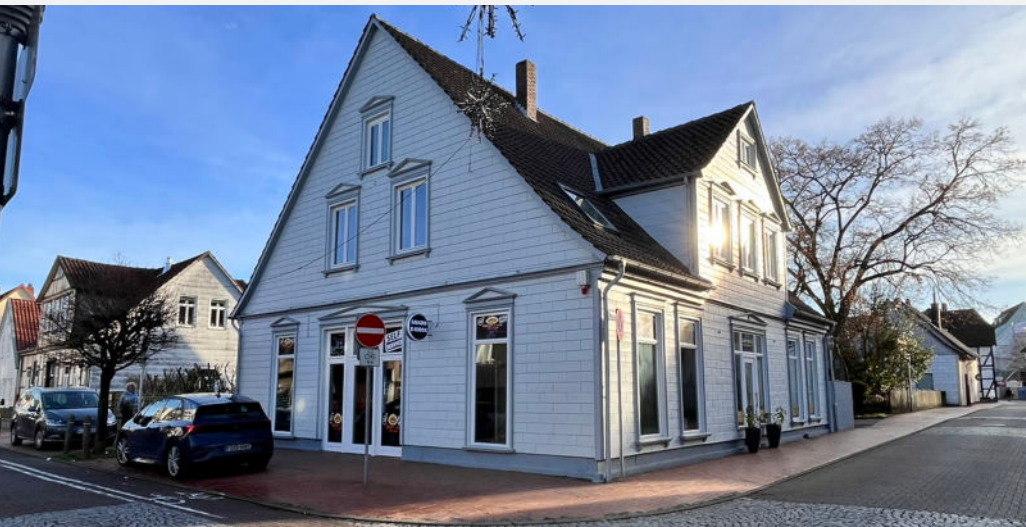
SANIERUNG EINES GEBÄUDES IN DER HANNOVERSCHEN NEUSTADT: VOR UND NACH DER SANIERUNG.
