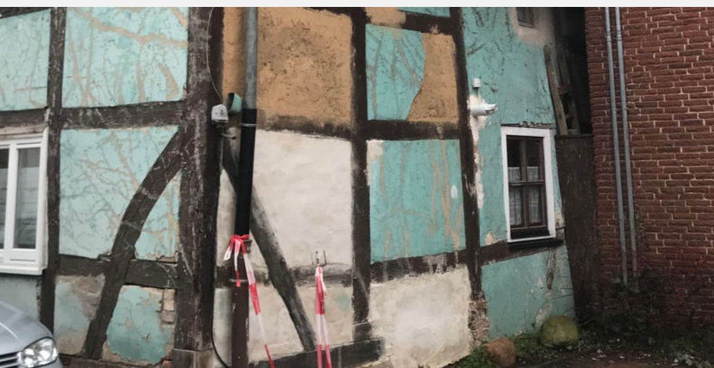
OBEN: SANIERTES GEBÄUDE IN DER KLEINEN BAHNHOFSTRASSE. UNTEN: GEBÄUDE MIT SANIERUNGSBEDARF IN DER SCHMIEDESTASSE.
